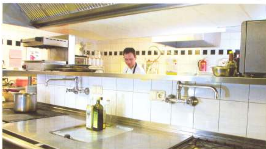
Eine Trennwand zwischen warmer und kalter Küche ist vernünftig, von Eibach aber auch so konzipiert, dass sich die Köche sehen können und für den „kalten Koch“ nicht die Sicht nach draußen versperrt wurde.
