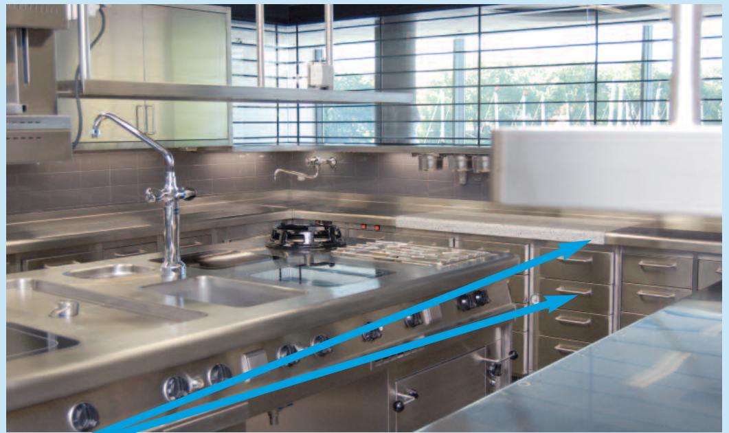
Glattflächige Möbelfronten sind mit Bügelgriffen (ohne Griffleisten) versehen. Hygiene und Ergonomie ist an allen Arbeitsplatten mit durchgehend verschweißten, fugenlosen Flächen und runden Vorderkanten vorhanden. Auch beim Material-Mix mit den Übergängen von CNS zu Marmor wird auf einfaches Reinigen Wert gelegt.
