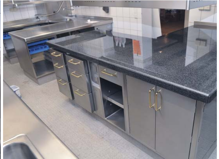
Unter dem Pass: ein von beiden Seiten zugängiger Wärmeschrank.
